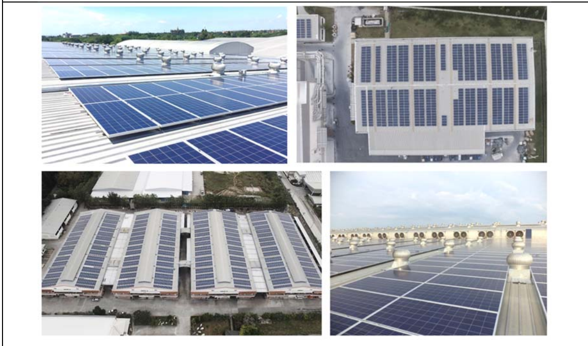
โครงการโรงไฟฟ้าพลังงานแสงอาทิตย์บนหลังคา
